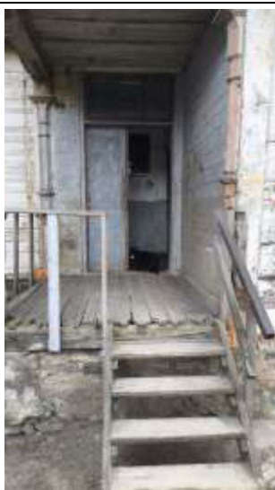
Kāpņu telpas ārdurvis
